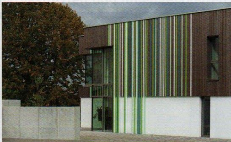
Beim Bau des Therapiezentrums Gößweinstein hatten die Verantwortlichen die Baukosten durch die Bausoftware NOVA AVA im Blick. Abb.: grimm_architekten BDA
